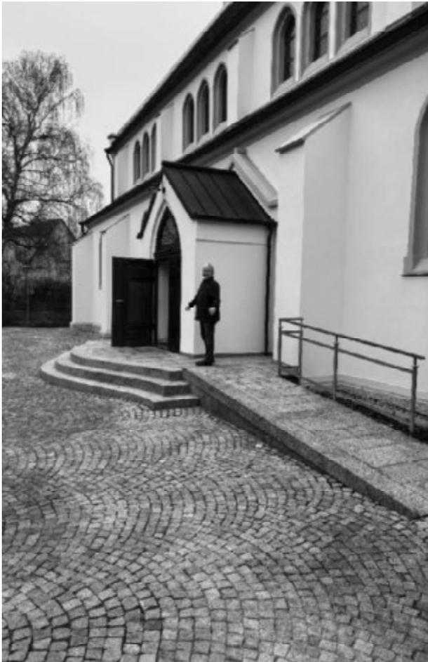
Im Zusammenhang mit der Sanierung des Daches und der Fassade der Kirche Ostrach wurde der Zugang über den Seiteneingang der Kirche Ostrach für Gehbehinderte Menschen verbessert. Die Firma AMTischler aus Ostrach hat die Türe so umgebaut, dass Sie nun mit Hilfe eines Knopfes automatisch auf und zugeht.
